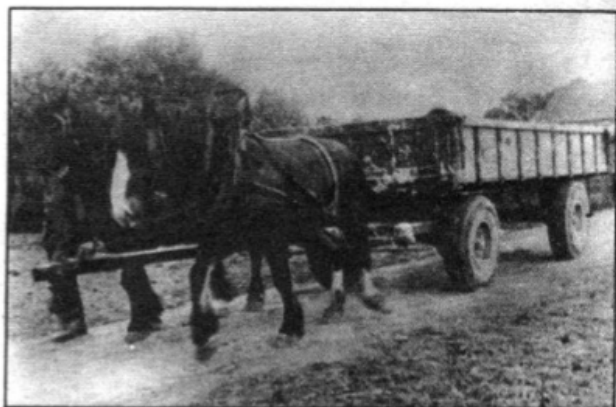
Ce véhicule est souvent utilisé dans le Nord de la France. Ce mode d'attelage permet de recueillir la totalité des efforts dépensés par les chevaux. Attelé à 5 chevaux de front comme dans le Boulonnais, il supporte la comparaison avec tout autre mode de traction.
