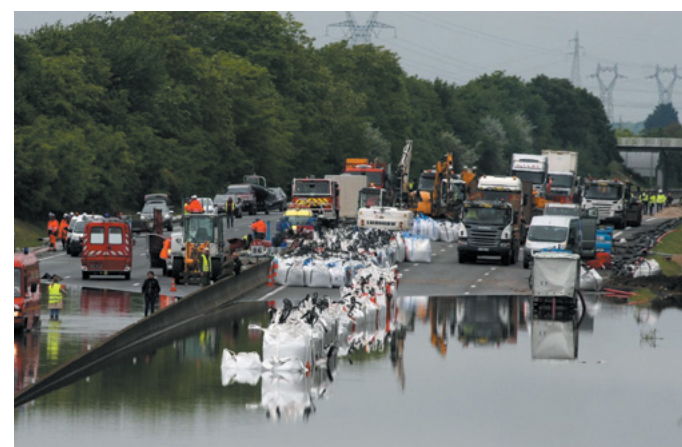
Deux conséquences des inondations sur le système alimentaire : champ noyé dans la Manche en février 2020 et autoroute A10 submergée dans le Loiret en mai 2016. Les inondations et l'humidité du printemps 2016 ont réduit de plus de moitié les rendements du blé dans les départements les plus touchés comme le Loiret ou la Seine-et-Marne 17 , tout en bloquant certains axes de circulation majeurs. Crédits : © Thibault Lorin ; Roland45, CC BY-SA, Wikimedia Commons.
